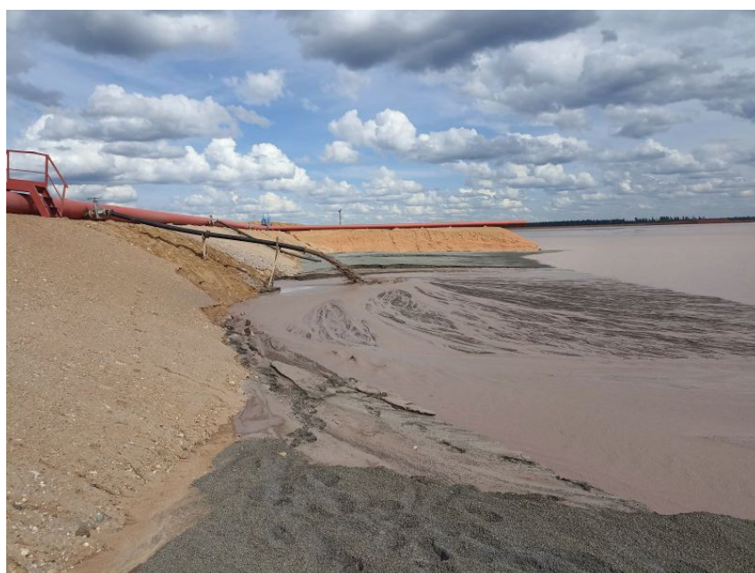
Рис. 7. Намыв хвостов на пляже Ломоносовского ГОКа Fig. 7. Inwash tails on the beach of Lomonosovsky ore mining and concentrating plant.
